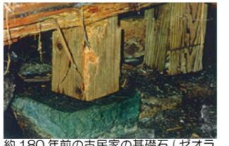
約180年前の古民家の基礎石(ゼオライト)。大引きなどは激しく腐朽しているが、基礎石と床束の接合部の腐れは全く無かった。
